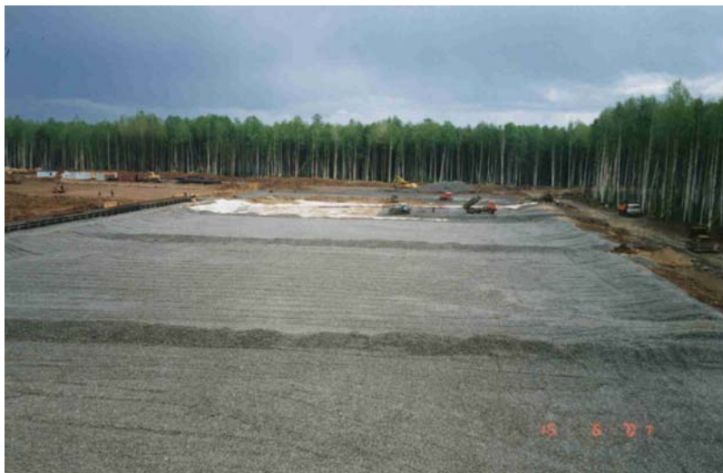
Подготовка основания штабеля. Месторождение «Воронцовское» (Свердловская область)
